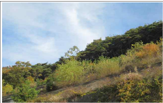
사면(시점부-상행) STA.0+110 3단 수목
