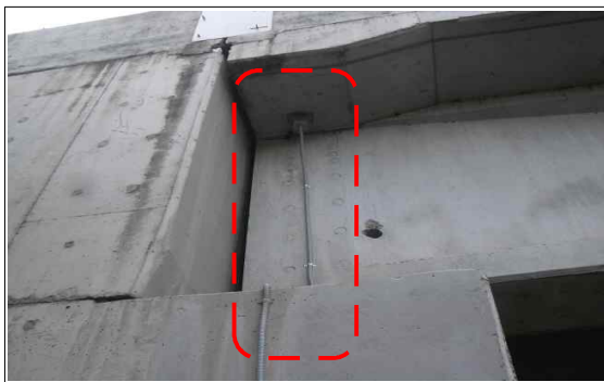
상행선 S1 유도배수관 기존 길이부족 구간 보수
