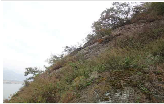
사면(중점부) STA.0+60 1단 뜯돌
