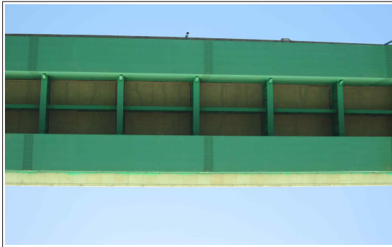
바닥판 하면 균열보수 현황
