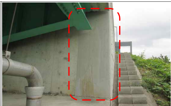
A2 교대 홍벽 기존 누수흔적 보수(양호)
