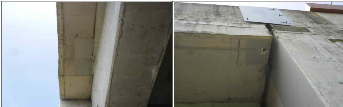
상행선 S4 바닥판하면 기존 그을음 부위 보수
