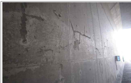
하행선 벽체 S1 기준 균열 보수
