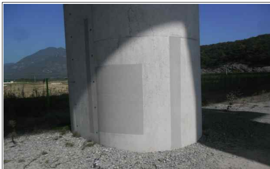
상행선 P7 기둥부 균열보수(양호)
