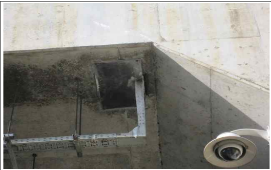
상행선 슬래브하면 S1 트레이 연결부 보수
