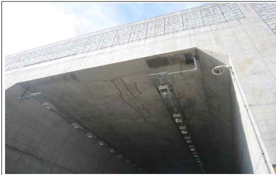
상행선 슬래브하면 S1 결노 보수
