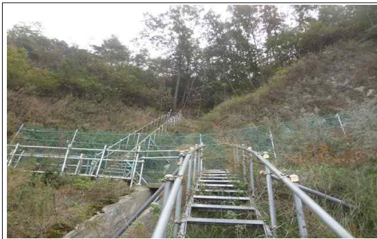
사면(중점부) 점검사다리 및 1소단배수로 낮은울타리 설치
