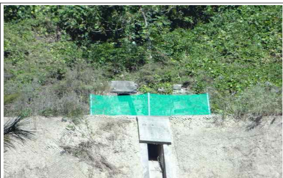
사면(시점부) STA.0+80 1소단배수로 낮은울타리 설치
