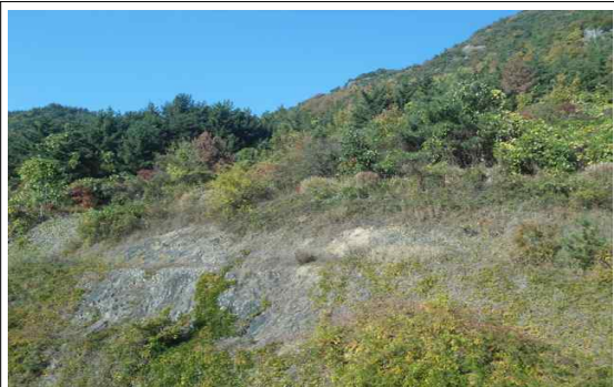
사면(중점부) STA.0+185 3단 식생불량 및 표층유실
