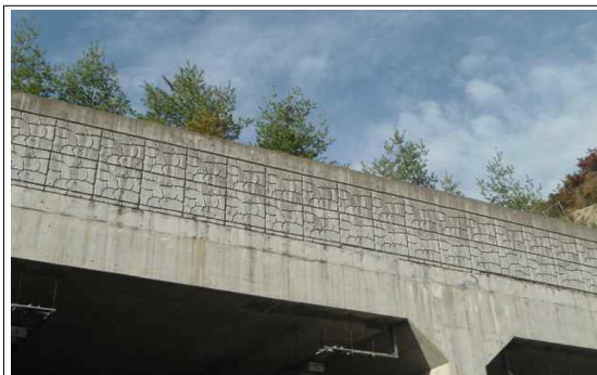
시점부 갭문 상행선 문양콘크리트 박락 보수
