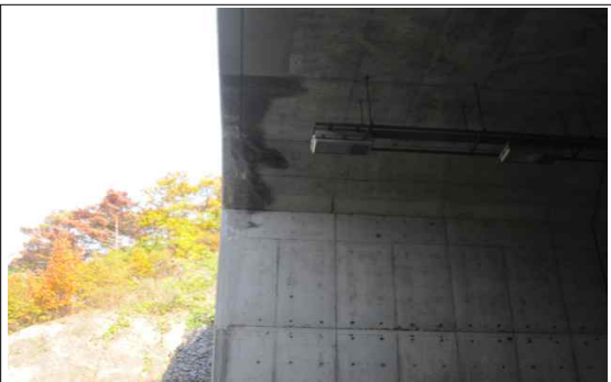
하행선 슬래브하면 백태 보수
