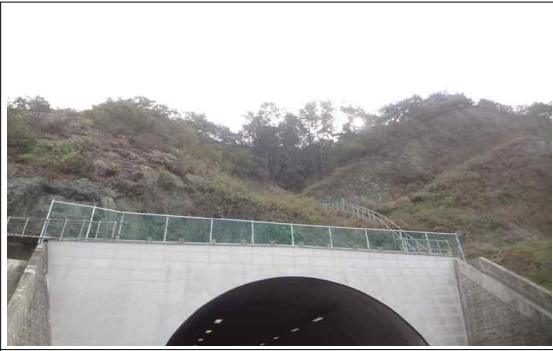
사면(중점부) STA.0+40~60 갯문배면 울타리 설치
