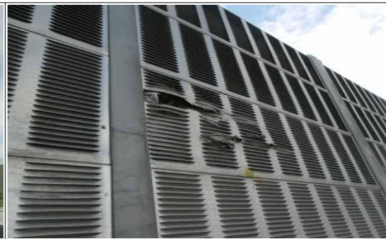
하행선 S15 차량충돌에 의한 방음벽 변형 및 파손
