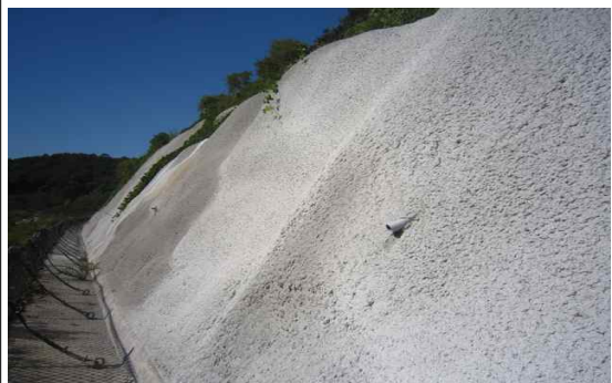
2단 슛크리트 시공 (27.00~27.06K 지점)
