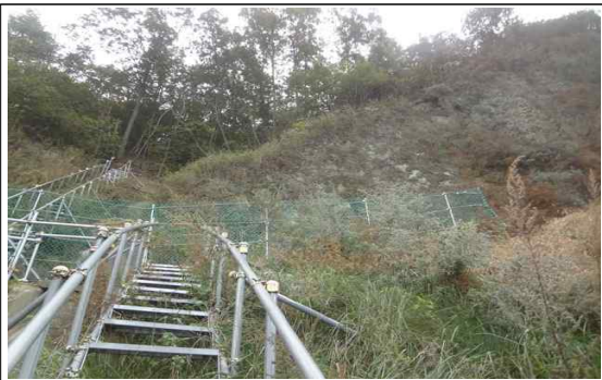
사면(중점부) 점검사다리 및 1소단배수로 낮은울타리 설치
